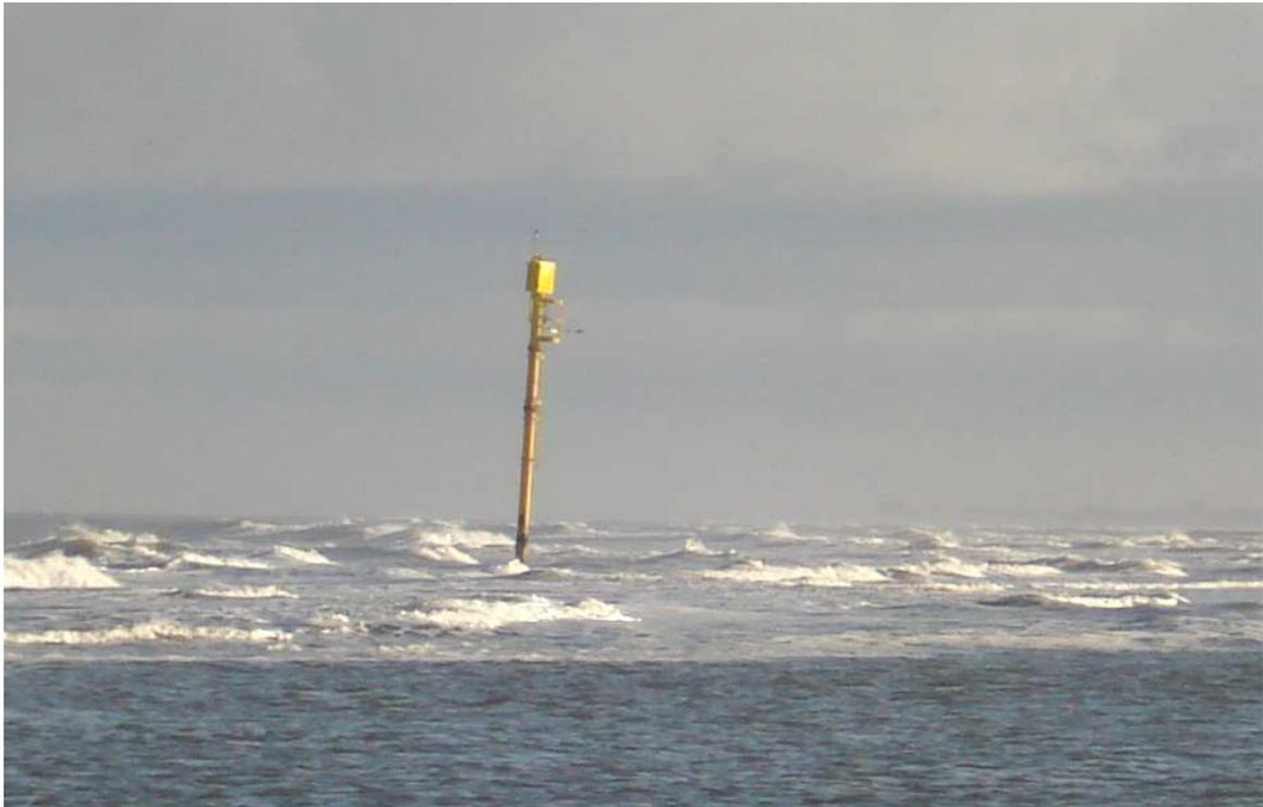
Abbildung 5.3: Leichte Schrägstellung des Messpfahls nach der Sturmflut. (Aufnahmedatum/-uhrzeit: 2007:11:16 10:57:08)
