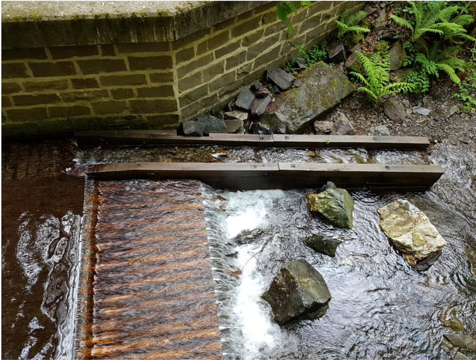
Abb. 106 Pegel Breitenbeek mit Gewässersohlgleite
