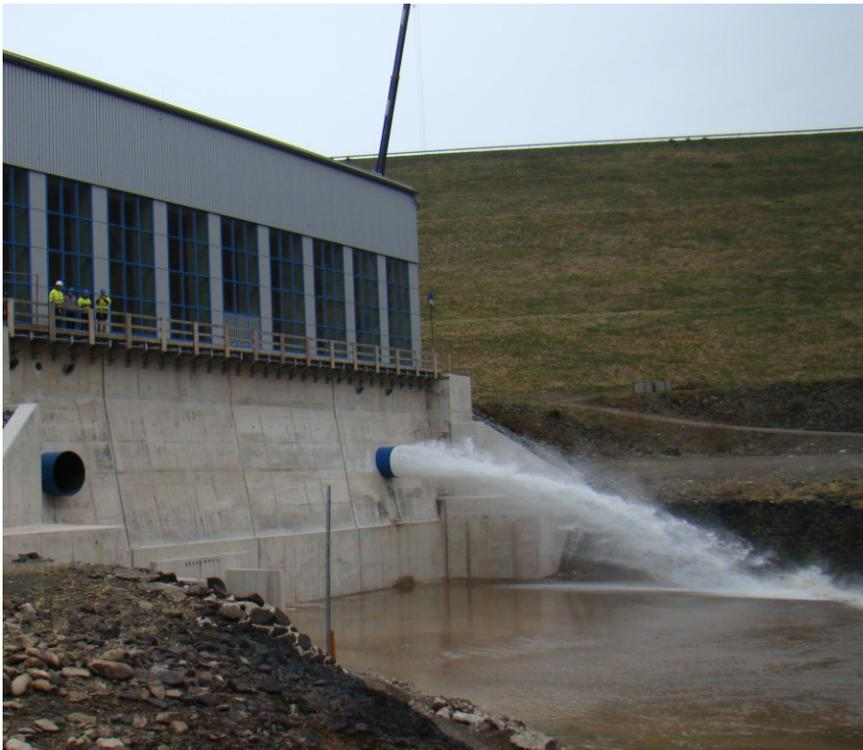
**Abb. 73 Odertalsperre Hauptsperre Abgabe bei entleertem Unterwasserbecken**
