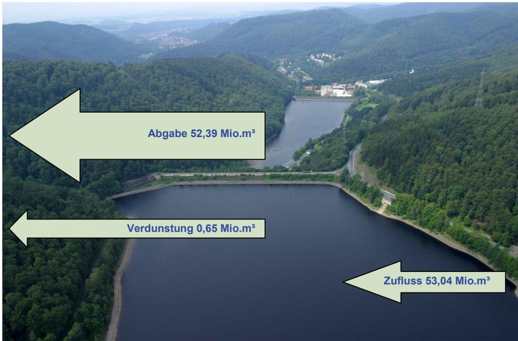
Abb. 111 Berechneter Wasserhaushalt der Odertalsperre Variante\_D
