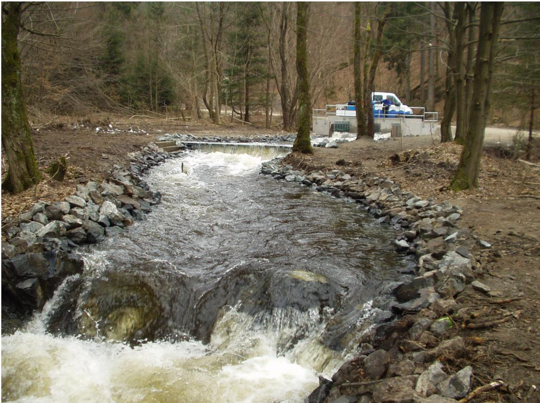
**Abb. 27** Unterwasserabgabe der Odertalsperre Ausleitung Breitenbeek
