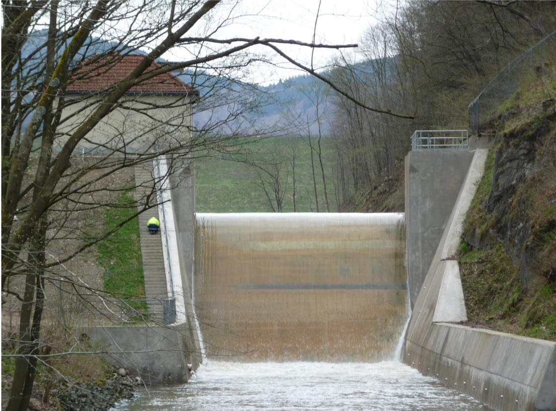
**Abb. 75 Odertalsperre Unterwasserbecken Abgabe über feste Wehrschwelle Luftseite**
