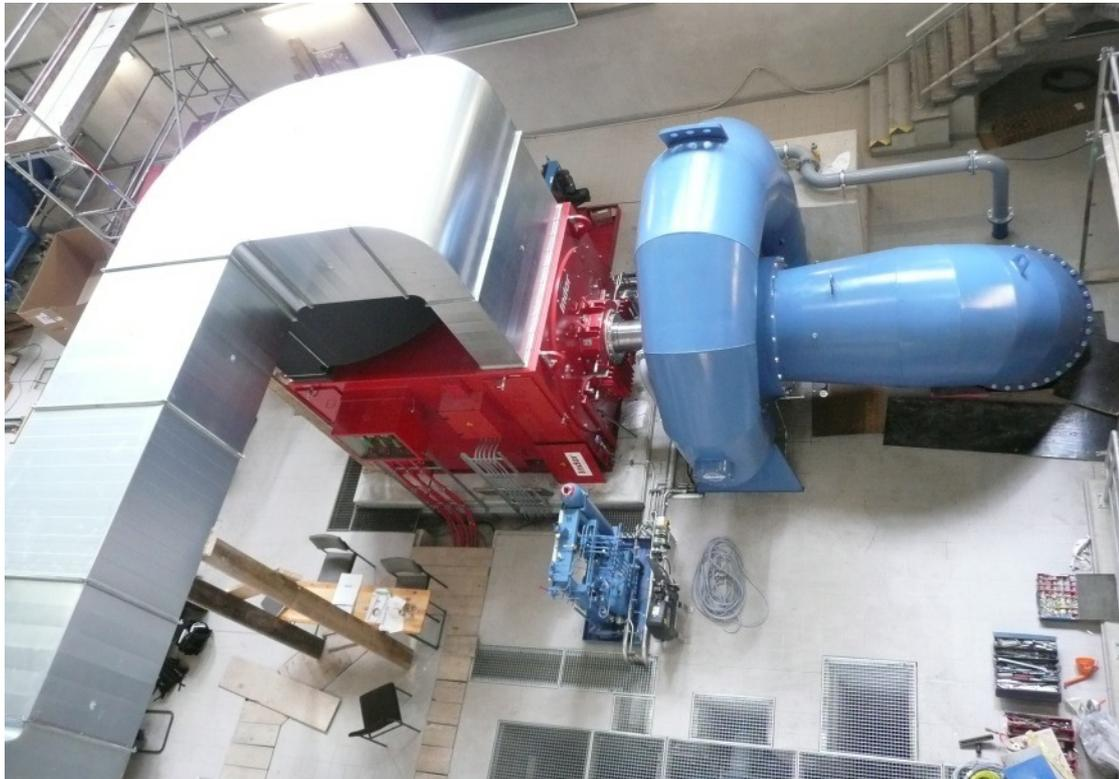
**Abb. 84 Oderkraftwerk seit 2013 mit neuer Turbine, Generator und Abluftkanal**
