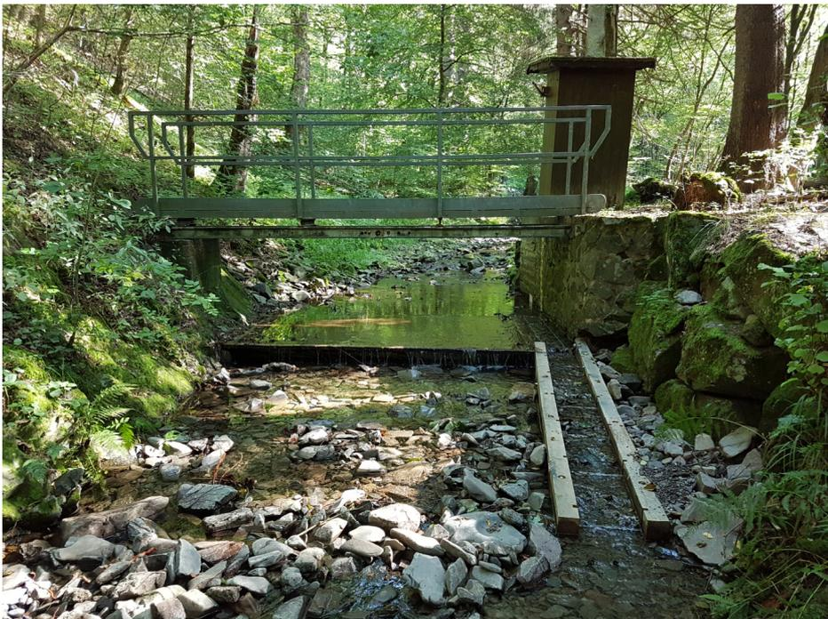
Abb. 107 Pegel Breitenbeek Überlauf mit Gewässersohlgleite
