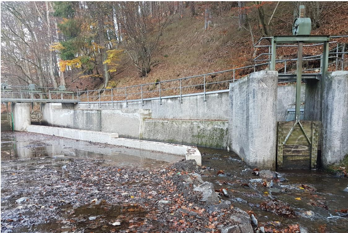
Abb. 108 Sperrlutter Überleitungswehr Fisch- und Makrozoobenthosaufstieg
