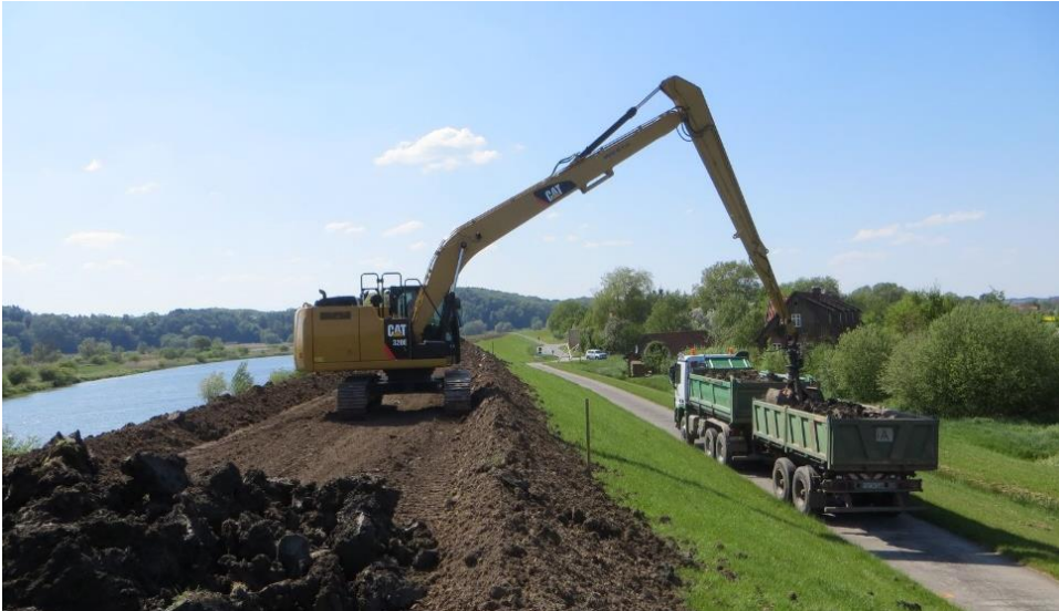
Deichkroneninstandsetzung vor Herrenhof
