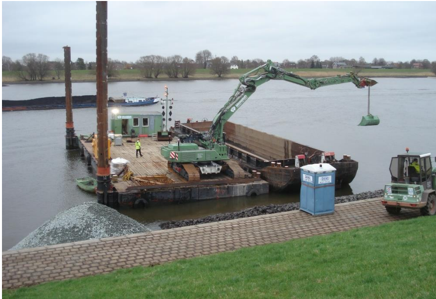
Arbeiten am Schüttsteindeckwerk im Bereich Vogtei Neuland
