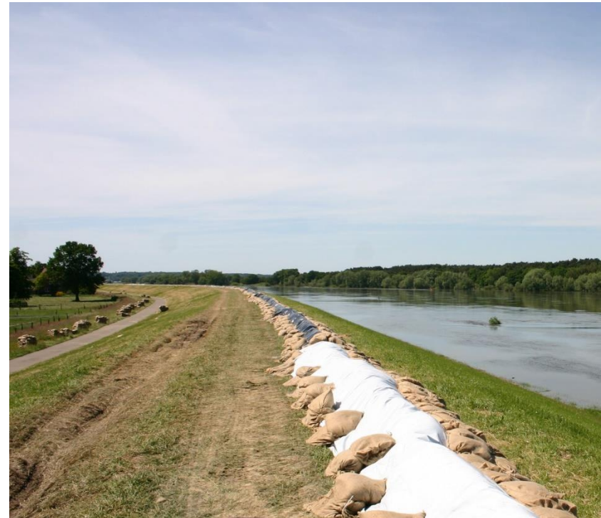
Hochwasser 2013 im Bereich Barförde
