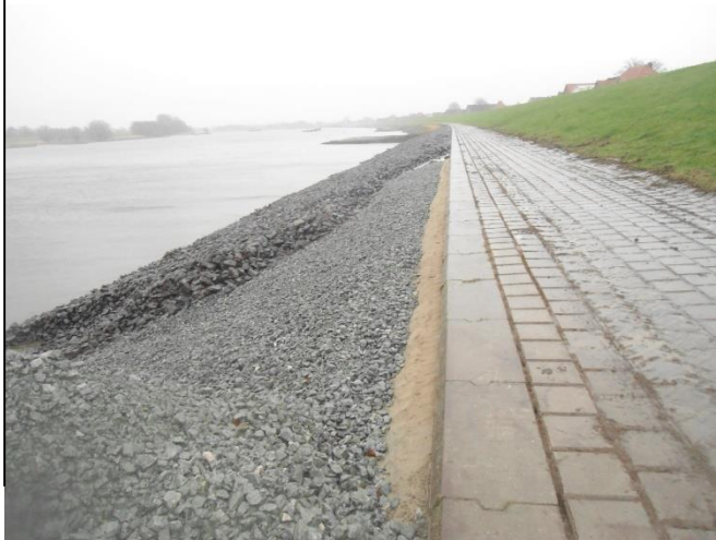
Arbeiten am Schüttsteindeckwerk im Bereich Vogtei Neuland
