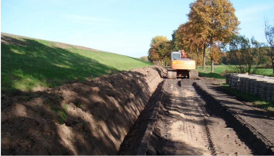
Schadensbeseitigung nach 2013 zwischen Barförde und Hohnstorf
