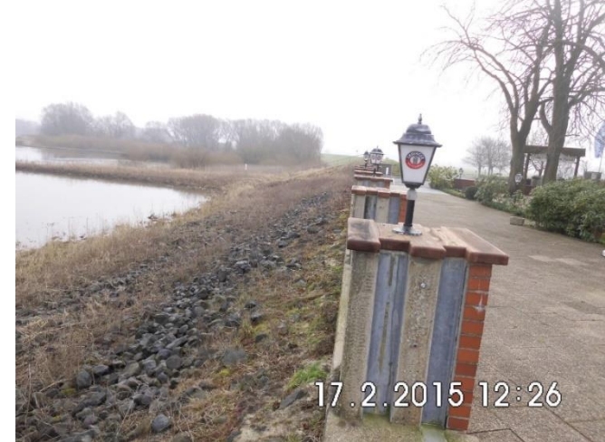
Vorhandene HWSW muss gem. des NDG erhöht und verstärkt werden.
