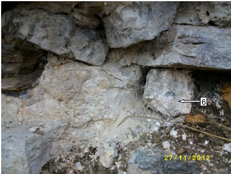
Bild 26: Detail zu Bild 25, nach Abstemmen, daraus: Probe 6/1 - Mörtel Probe 6/2 - Sandstein jeweils für Festigkeit + WA
