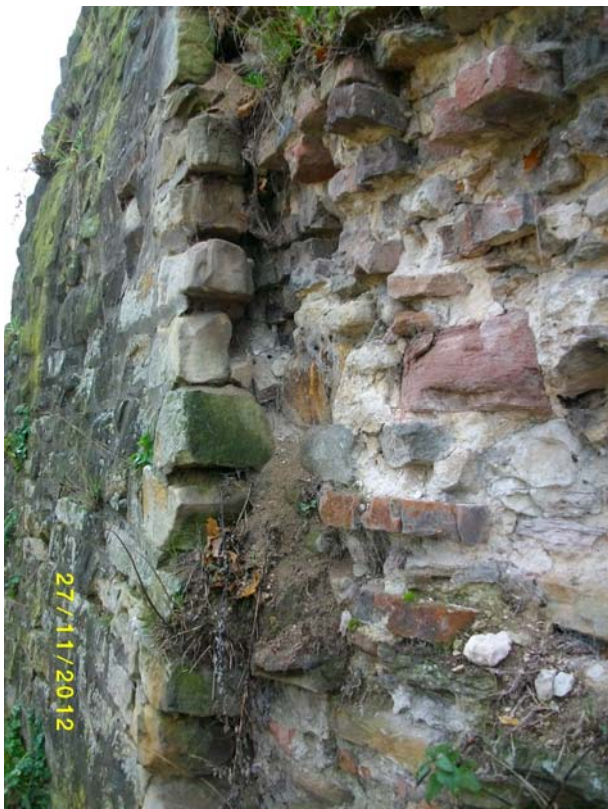
Bild 29: Rest der Mauerverblendung, z. T. hohllegend
