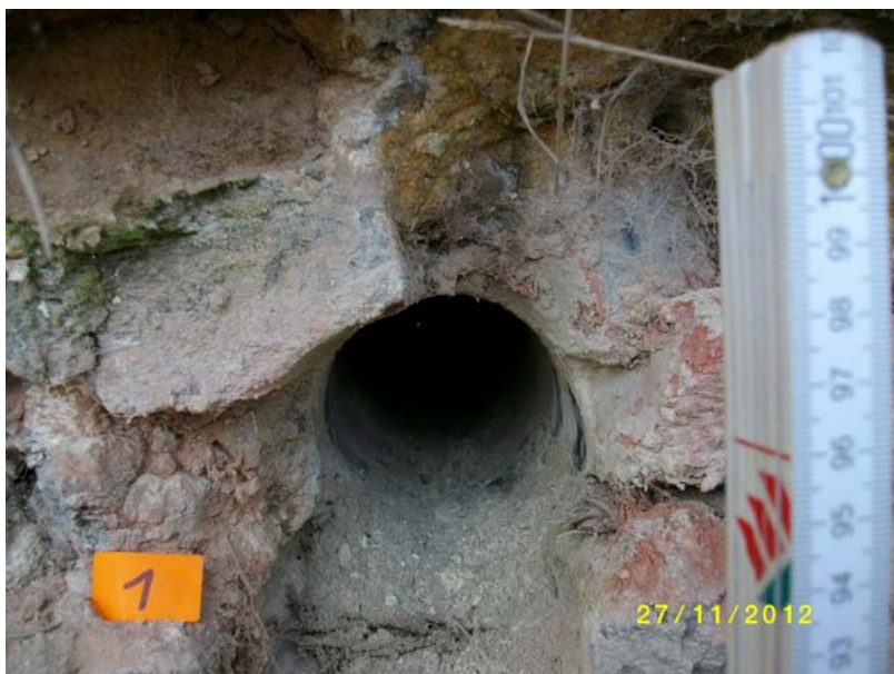
Bild 3: Bohrloch von BK 1; Bohrtiefe 75 cm
