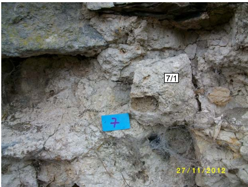
Bild 27: Detail aus Bild 24 Mörtelprobe 7/1 für Wasseraufnahme
