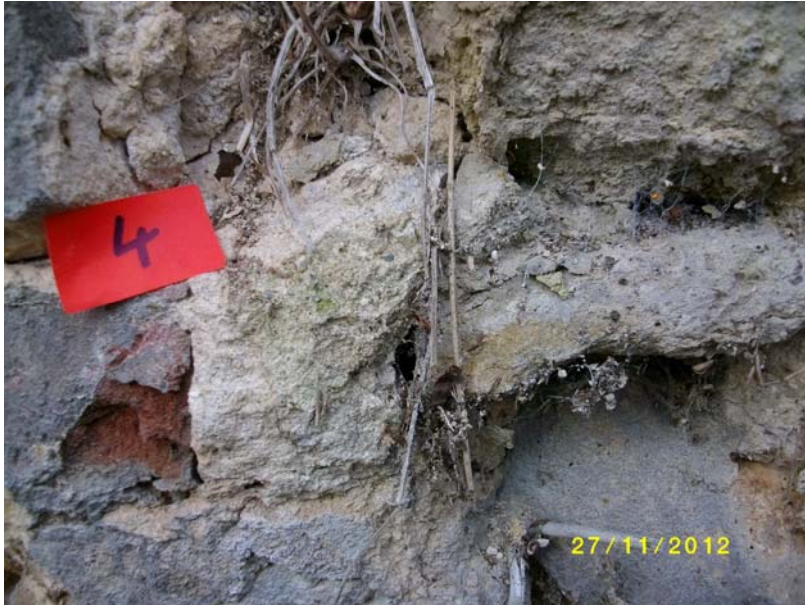
Bild 22: Detail zu Bild 12; Ziegel von Mörtel umhüllt Probe 4/1-Zie für WA
