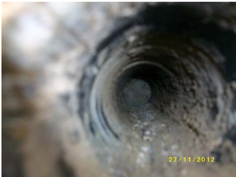
Bild 20: Bohrloch von BK 3; Bohrtiefe 53 cm
