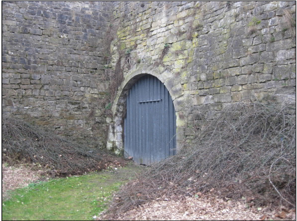
Abb. 2.1: Tor in die Kasematte
