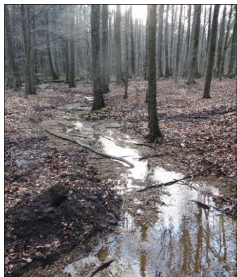
Sohlhebung durch Kieseinbau in Waldlage Quelle: S. Brandenburg
