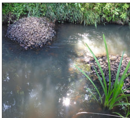
Die Einbauten initiieren einen gewundenen Stromstrich und erhöhen die Tiefenvarianz
