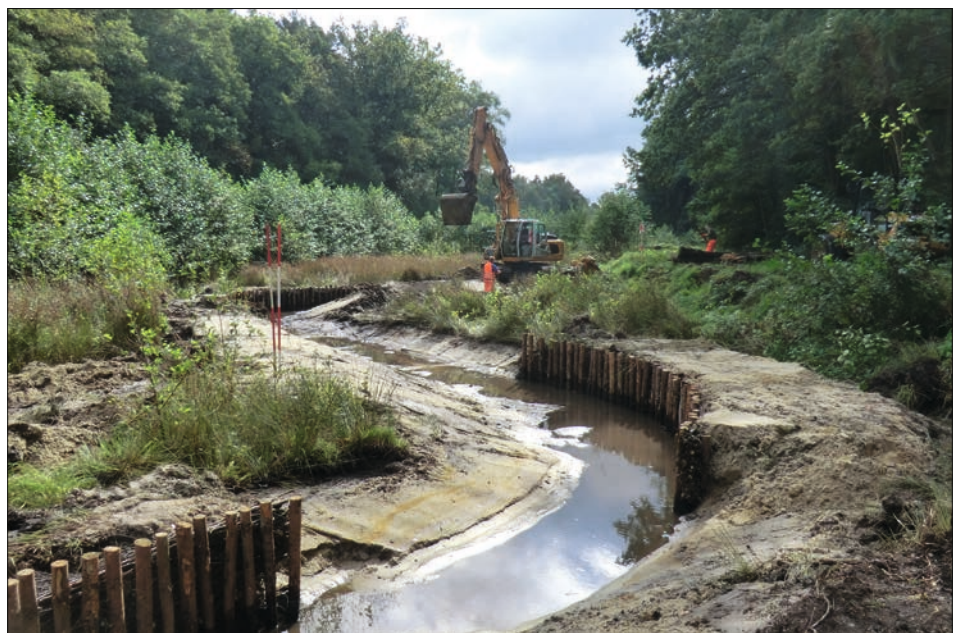
Verlegung des Bachbettes zurück in die taltiefste Linie: Reisigfaschinen sichern instabile Prallufer
