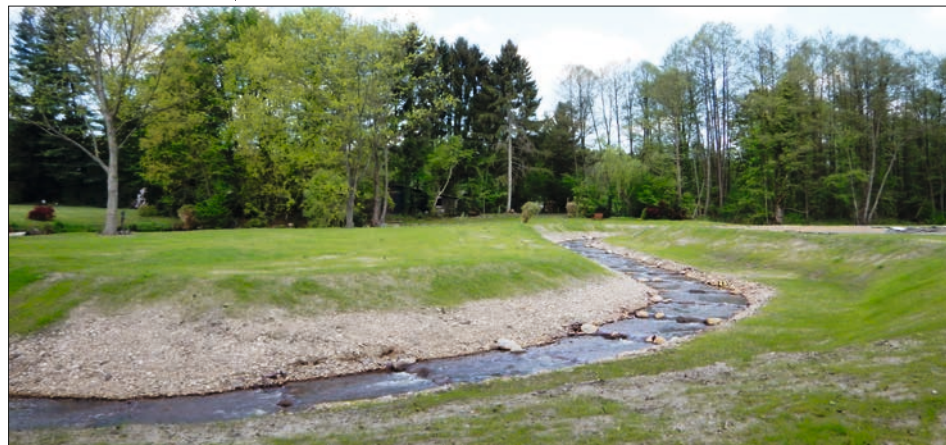
Über die Beckenstruktur im Raugerinne kann der Höhenunterschied auf kurzer Distanz abgebaut werden und der neue Gewässerabschnitt ist ökologisch durchgängig für Fische und Wirbellose
