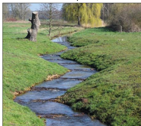
Siede Sohlabsturz S3 vor (oben, 2016) und nach dem Umbau zur Sohlgleite (unten, 2019) Quelle: S. Nolte (unten)
