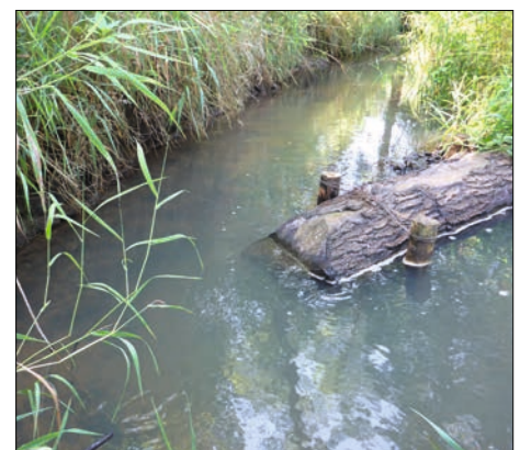
Die Einbauten initiieren einen gewundenen Stromstrich und erhöhen die Tiefenvarianz
