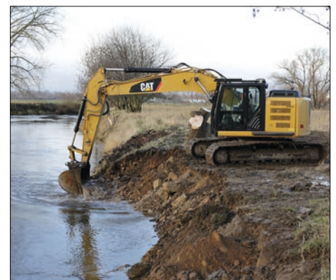
Deckwerksrückbau an der Leine bei Betheln Quelle: M. Jürging/U. Schmida
