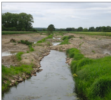
Sekundärauen reduzieren den Eintrag von Nährstoffen und erhöhen den Hochwasserrückhalt
