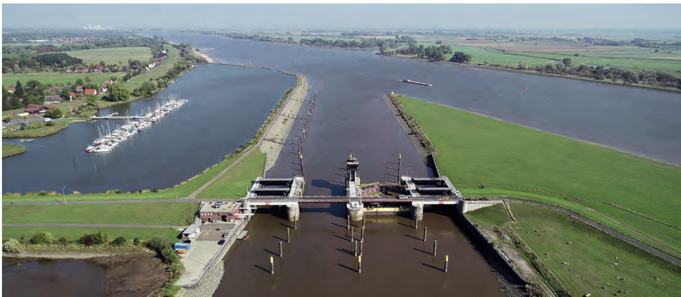
Das Huntesperwerk sichert u.a. Oldenburg vor Sturmfluten aus dem Wesergebiet. Oberhalb der Anlage – hier im Bildvordergrund – beginnt die Schutzdeichlinie.
