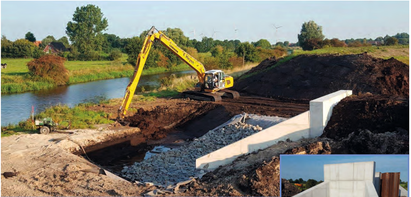
Sorgt künftig für die Regulierung des Wasserstandes im Hochwasserpolder Wittmund: Das neue Auslassbauwerk - hier während der Bauphase.
