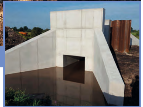
Sorgt künftig für die Regulierung des Wasserstandes im Hochwasserpolder Wittmund: Das neue Auslassbauwerk - hier während der Bauphase.
