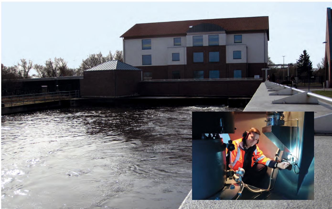
Bereits seit 2008 in Betrieb: Das Schöpfwerk in Hitzacker hat sich als Bestandteil der Hochwasserschutzanlagen für die Stadt u.a. 2011 und 2013 bewährt. Wichtig ist die Unterhaltung des Schöpfwerkes wie hier bei einer Öldruckprüfung durch Mathias Schlombs.
