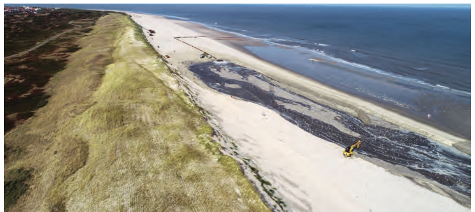
Unter dem Stichwort Building with Nature stehen die Strandaufspülungen, die – wie hier auf Langeoog – Dünenabbrüche verhindern und damit die Sturmflutsicherheit erhöhen.
