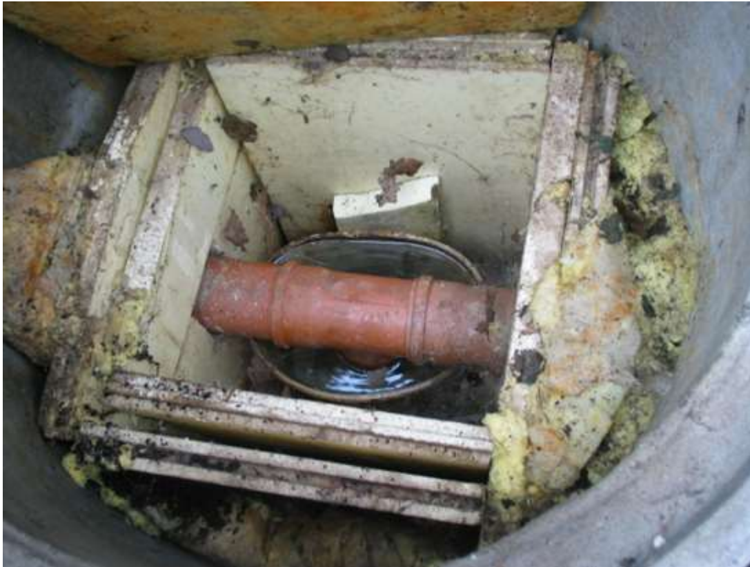
Kondensatabscheider mit Tauchung im Zinkeimer
