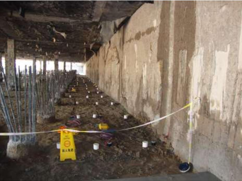
FGM® Qualitätskontrolle Schlitz- oder Bohrpfehlwandüberprüfung und Fugenkontrolle
