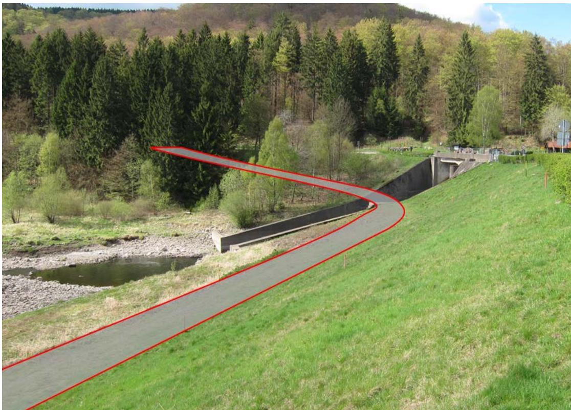
Abbildung 3-5: Vorsperrendamm mit bildlich schematischer Darstellung der Umfahrung auf der Berme
