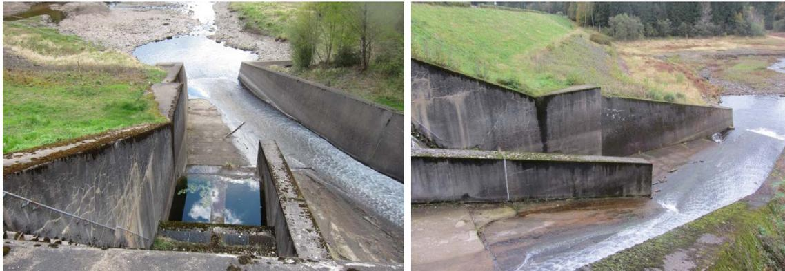
Abbildung 5-2: Schussrinne im Bereich der geplanten Brücke
