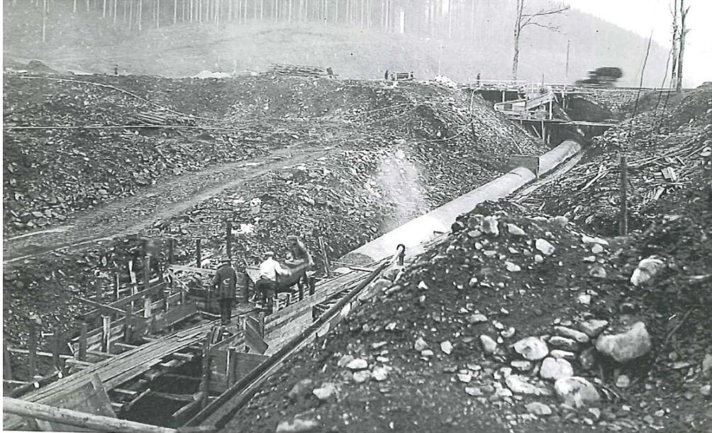
Abbildung 2-9: Foto aus dem Bautagebuch vom Bau des Grundablasses in offener Baugrube
