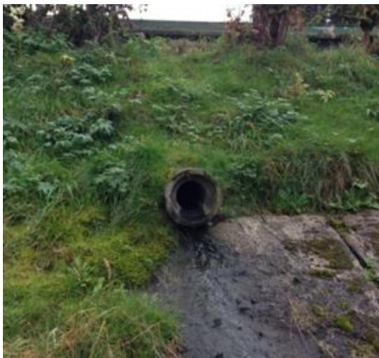
Abbildung 2-15: Einmündung einer Entwässerungsleitung in die Vorsperre oberhalb des Endes der vorhandenen Betonplattenabdichtung
