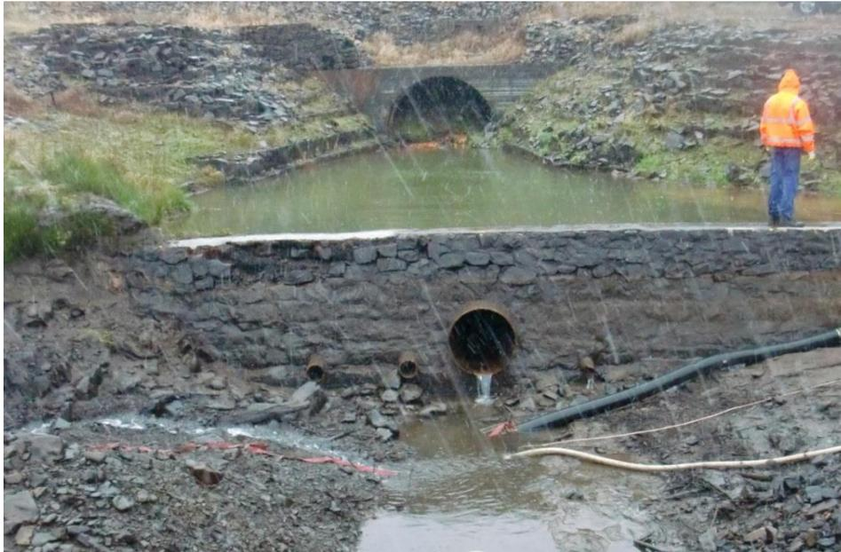
Abbildung 2-10: Vorhandenes Auslaufbauwerk des Grundablasses in der Hauptsperre (Freilegen des Rohren mit Wasserhaltung zur Kamera-Befahrung der Grundablassleitung 16.12.2011)
