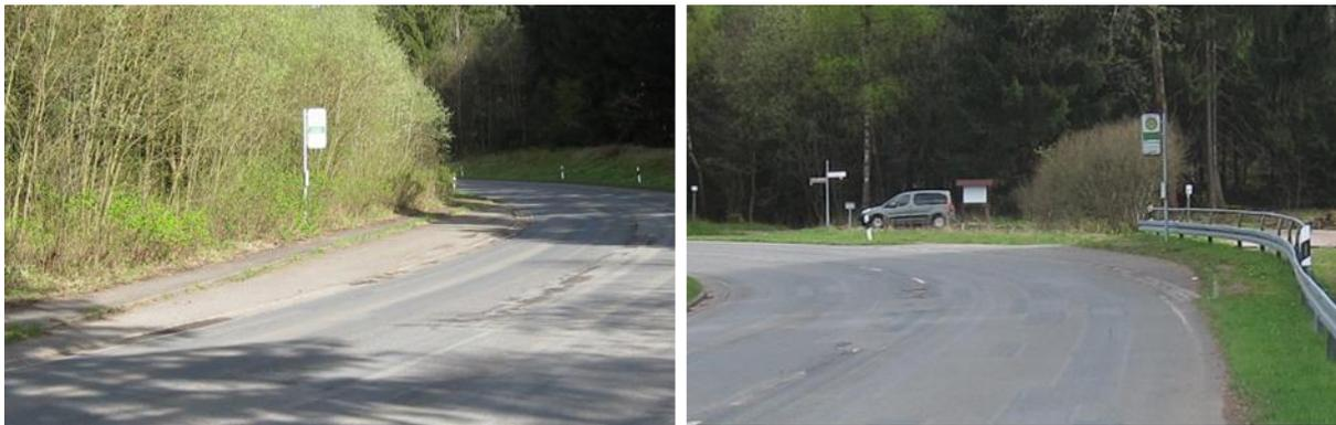
Abbildung 2-14: Bushaltestellen mit Haltebuchten in der Kurve südlich des Damms
