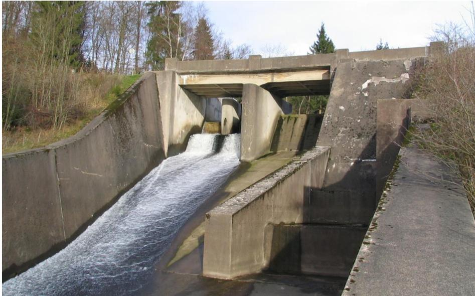
Abbildung 2-6: Bestehende Hochwasserentlastungsanlage auf Hauptsperrenseite
