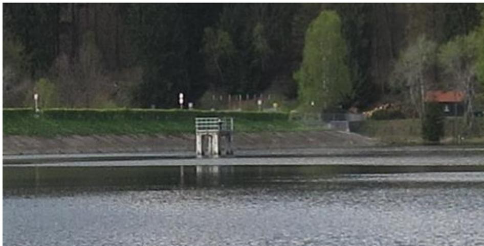
Abbildung 2-7: In der Vorsperre gelegener Grundablassturm mit Bedienebene über Wasser
