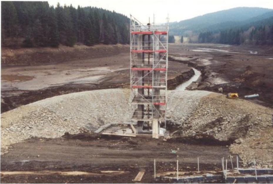
Abbildung 2-11: Sicherung des Grundablasses in der Vorsperre mit gitterbewehrtem Steinschüttdamm; Aufnahmedatum 02.12.1997
