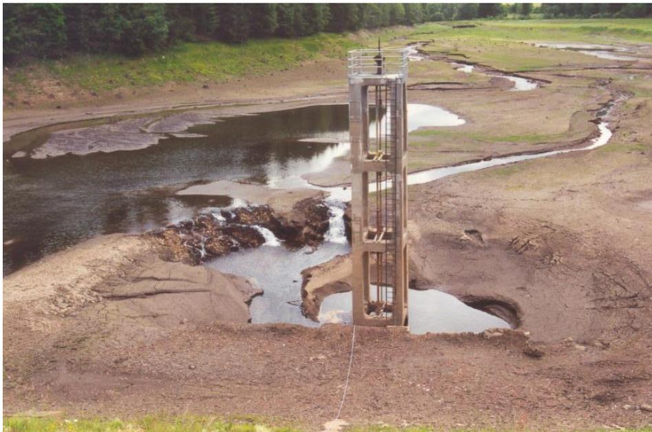
Abbildung 2-12: Verlagertes Sediment im Vorsperrenbecken und am Grundablass nach Fertigstellung der Sanierungsarbeiten an Wehr und Grundablass; Aufnahmedatum 07.03.1999
