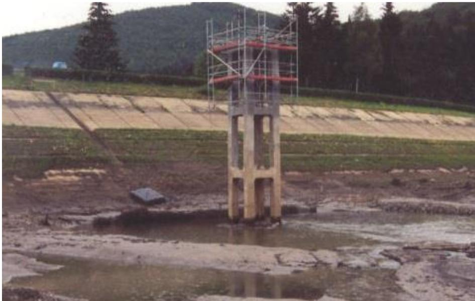
Abbildung 3-4: Ansicht der mit Sediment bedeckten Betonplattendichtung bei der Sanierung des Grundablassturms; Aufnahmedatum 07.09.1998
