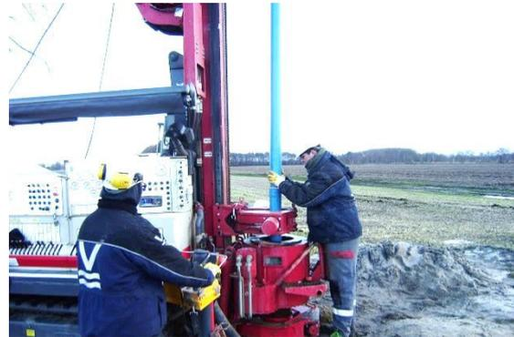
Abb. 64: Einsetzen eines Brunnenrohres beim Trockenbohrverfahren.
