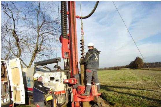
Abb. 63: Trockenbohrung einer Grundwassermessstelle.
