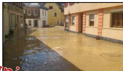
Überflutung in Stromberg am 25.06., im Hintergrund am Vortag abgelagertes Geschiebe der Hauptwelle (Copyright: SWR)
