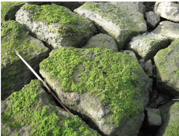
Foto 4: Algenbewuchs oberhalb der Wasserlinie
