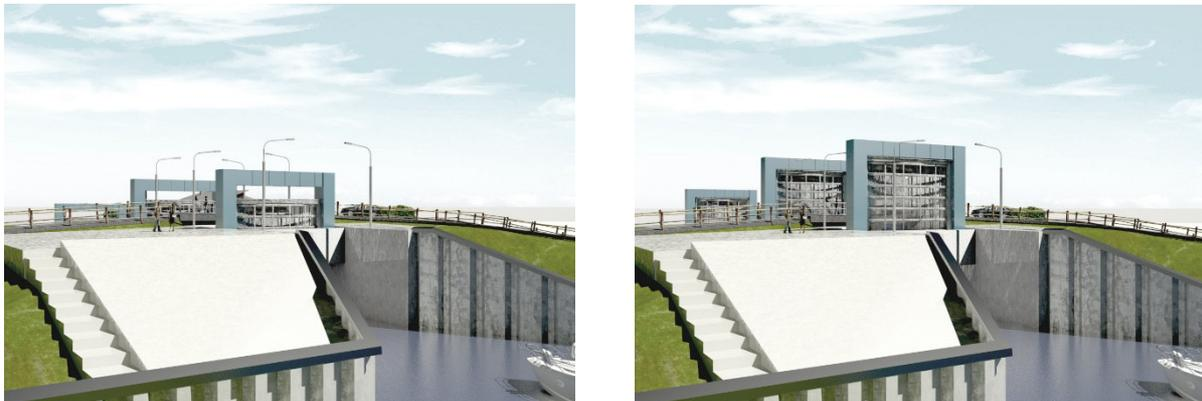
**Abbildung 5-3: Visualisierung einteiliges (rechts) und zweiteiliges Hubtor**
