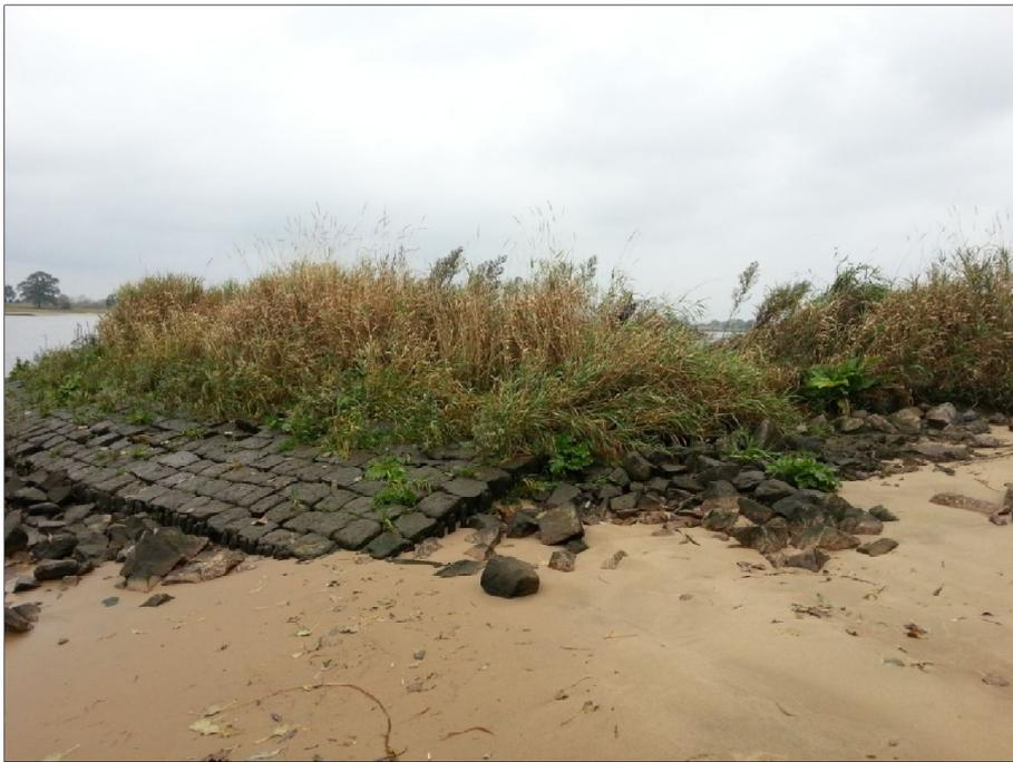
**Abbildung 3:** Typisches Schadensbild an den Deckwerken, hier im Bereich der Buhnenwurzel. Eigene Aufnahme 10/2014.
