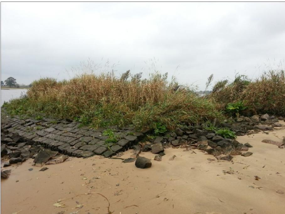
Abbildung 28: Typisches Schadensbild an den Deckwerken, hier im Bereich der Buhnenwurzel. Eigene Aufnahme 10/2014.
