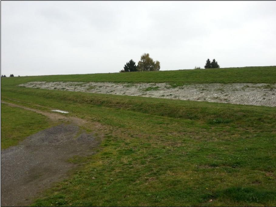
Abbildung 10: Zusätzliche Befestigung der Deich-Außenböschung mit Verkalit-Deckwerksteinen. Eigene Aufnahme, 10/2015.
