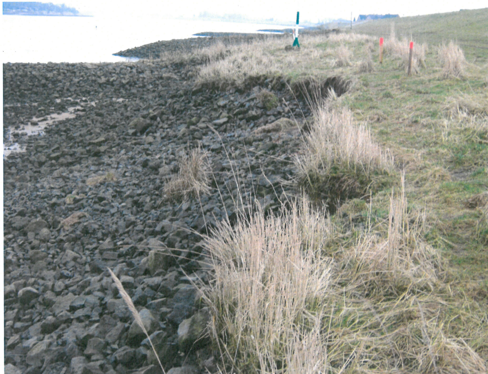
(Foto NLWKN, R. Martin, linksseitiges Elbeufer HDV 02 Abschnitt 1)
