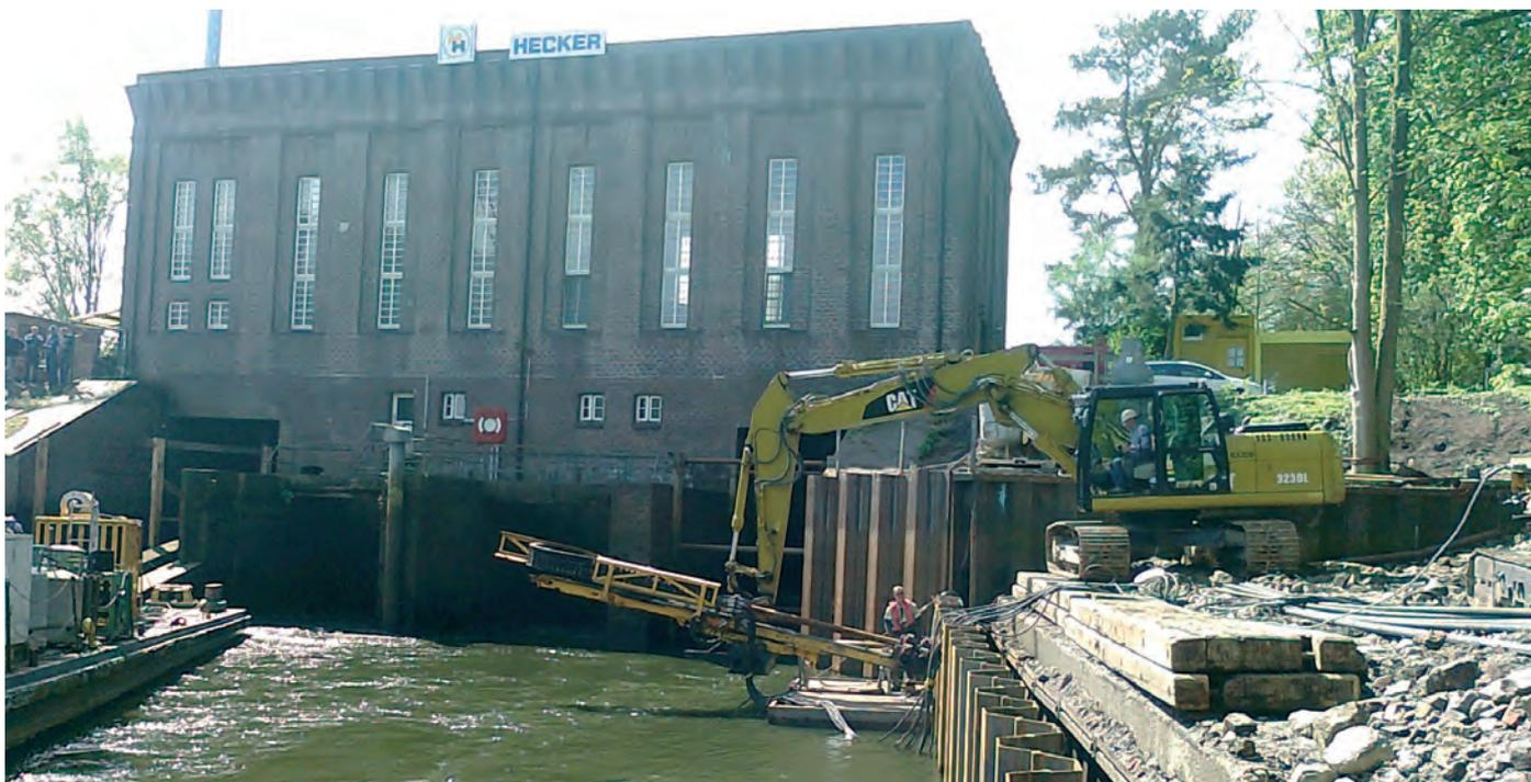
Baustelle Wasserkraftwerk Oldenburg: Die Anker der linken Leitspundwand werden gesetzt.
