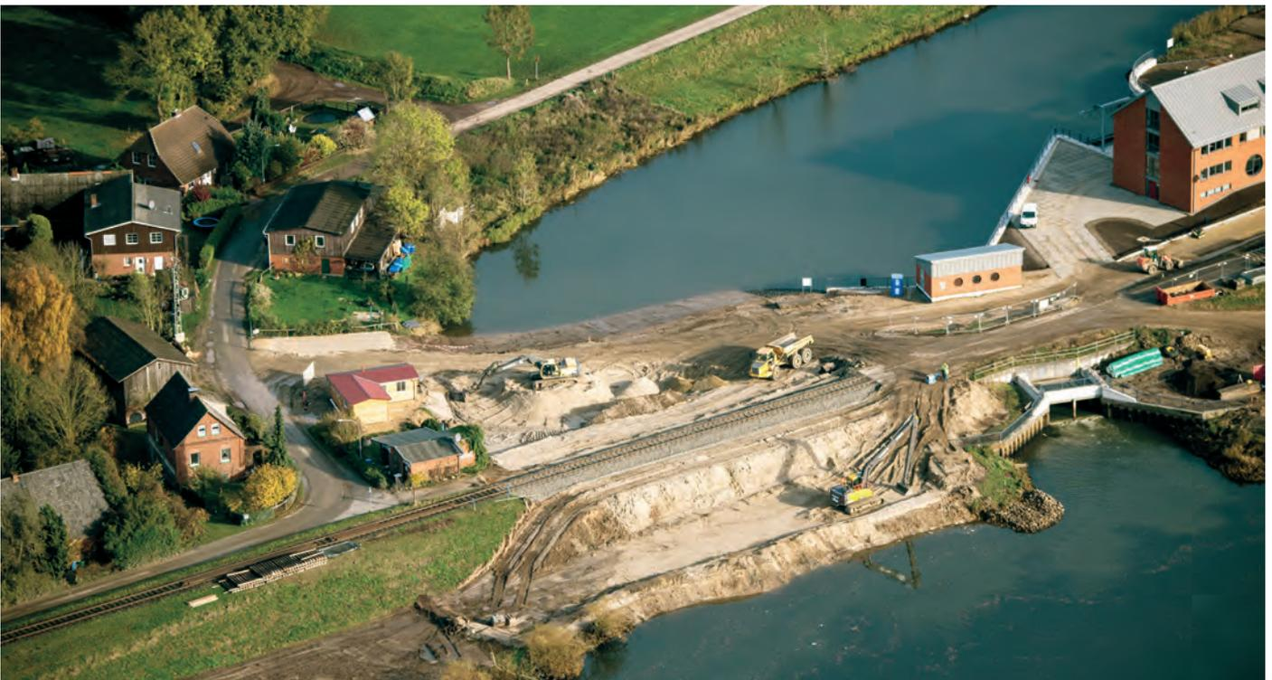
Blick auf das neue Schöpfwerk in Fahrenholz, das seit Oktober 2016 in Betrieb ist. Im hinteren Bereich ist der Fangedamm zu erkennen, der gleichzeitig zur Baustraße erweitert wurde. (Bildquelle: Wasserverband der Ilmenaaniederung)
