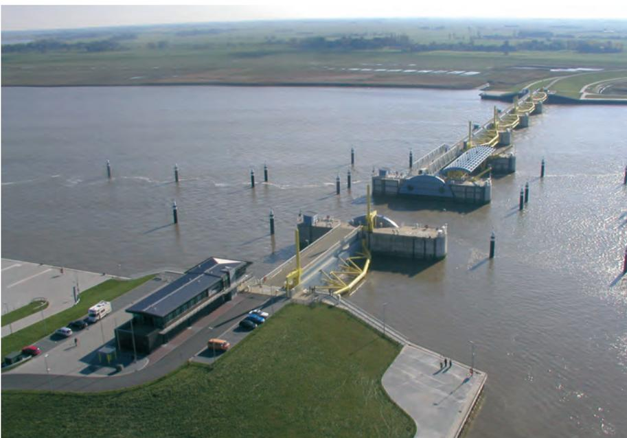
Das Emssperrwerk bei Gandersum: Die geplante flexible Tidesteuerung soll hier den Schlickeintrag in die Unterems vermindern.
