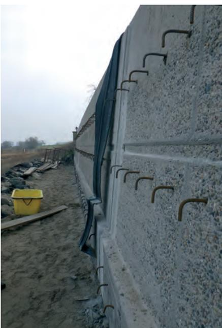
Mehr als einen Meter zu niedrig – die Hochwasserschutzwand in Wussegel wird jetzt erhöht und verstärkt.
