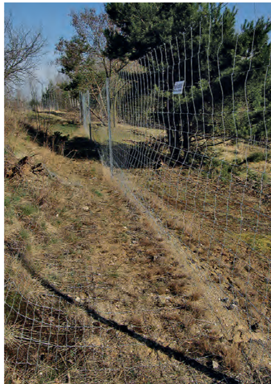
Für Gatterwild: 180 cm hoher Knotengitterzaun mit Schürze als Untergrabeschutz (Foto: B. Pott-Dörfer)
