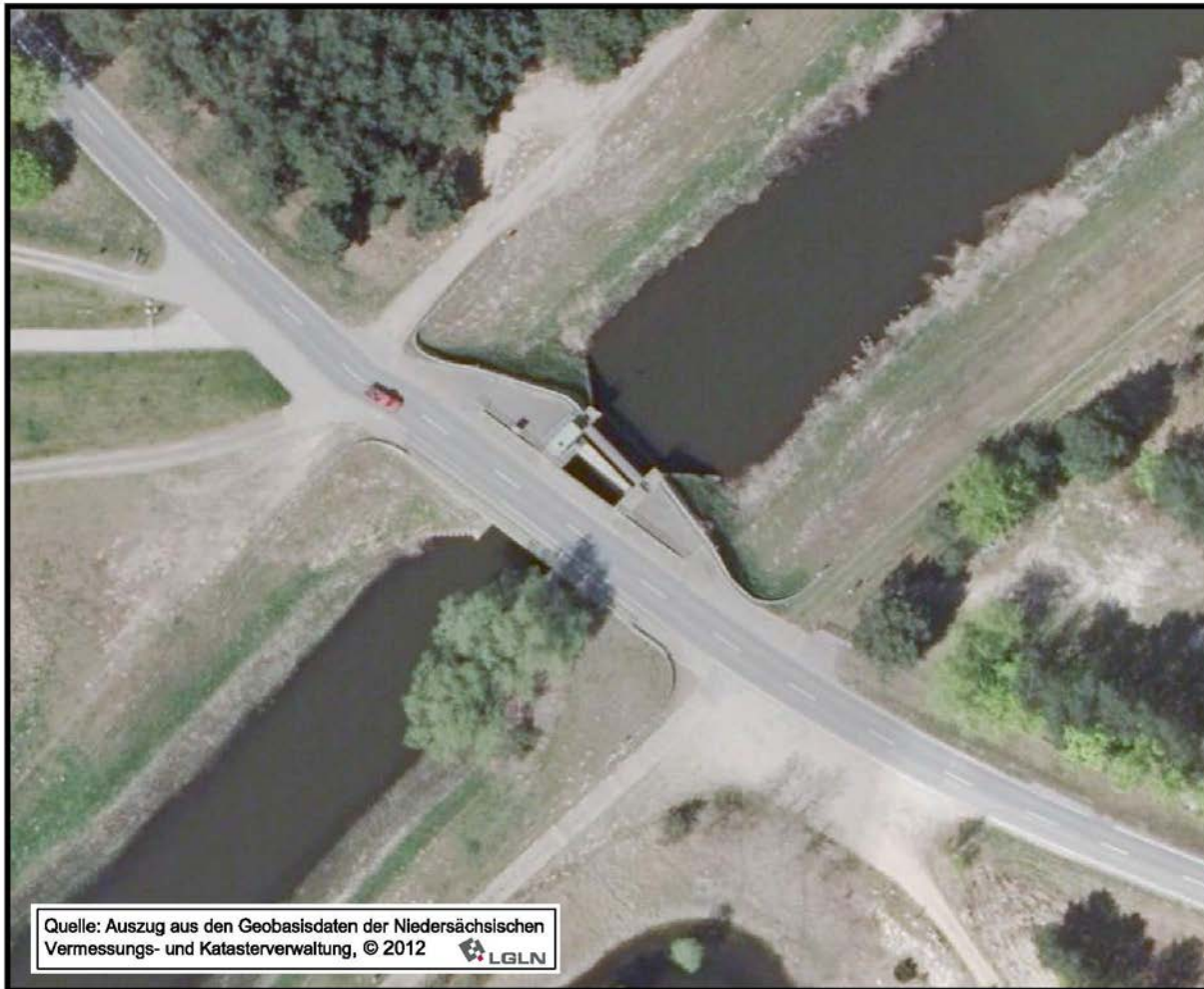
Abbildung 3 Vorhandene Wehranlage im Gewässer Löcknitz mit Straßenbrücke
