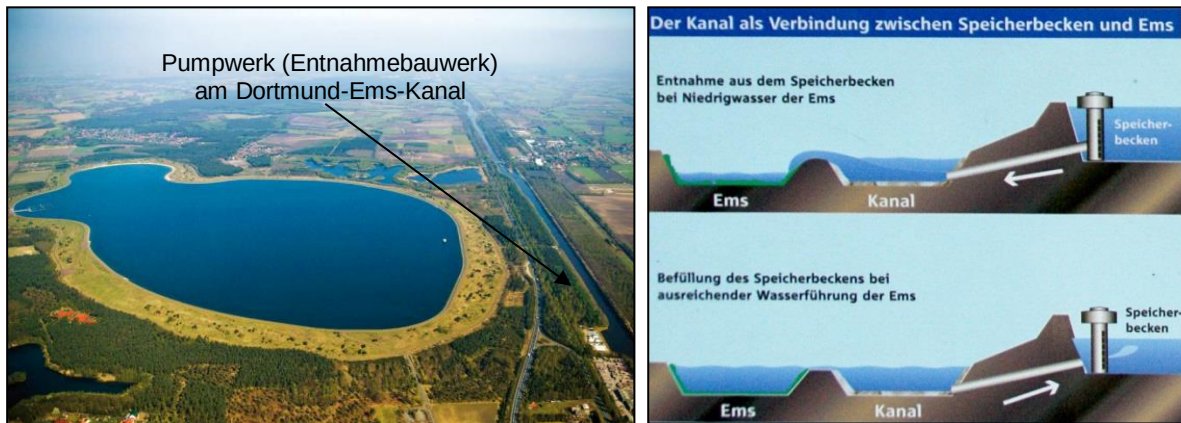
Abb. 4: Speicherbecken Geeste und Wasserentnahme aus dem Dortmund-Ems-Kanal (Quellen: Info-Broschüre der RWE Power AG bzw. Info-Tafel am Speicherbecken Geeste)
