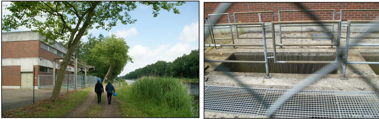
Abb. 3: Entnahmebauwerk am Dortmund-Ems-Kanal mit Rechenanlage eigene Aufnahmen vom 24.06.2015
