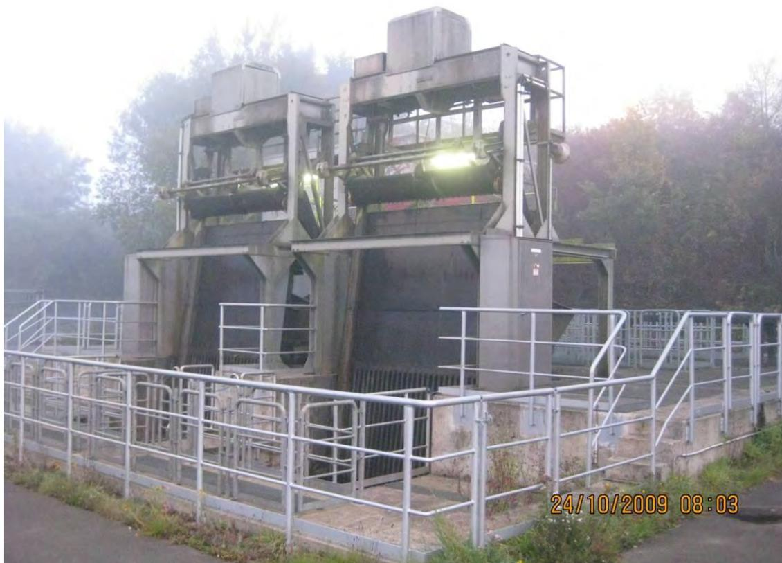
**Abbildung 8: Grobrechen (50 mm lichter Stababstand) des Einlaufbauwerks**
