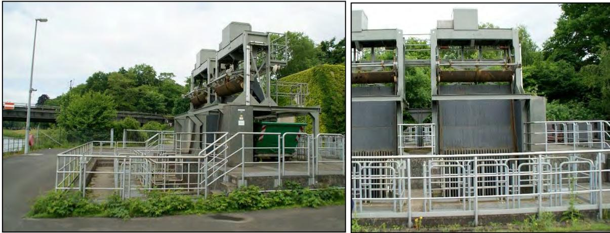
Abb. 2: Grobrechenanlage des Einlaufbauwerks am Dortmund-Ems-Kanal
