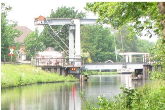
Abb. 12: Typische Hebebrücke über einem Entwässerungskanal.
