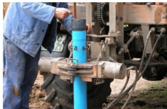
Abb. 56: Bau einer Grundwassermessstelle.
