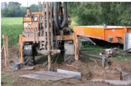
Abb. 55: Bohrung einer Grundwassermessstelle.
