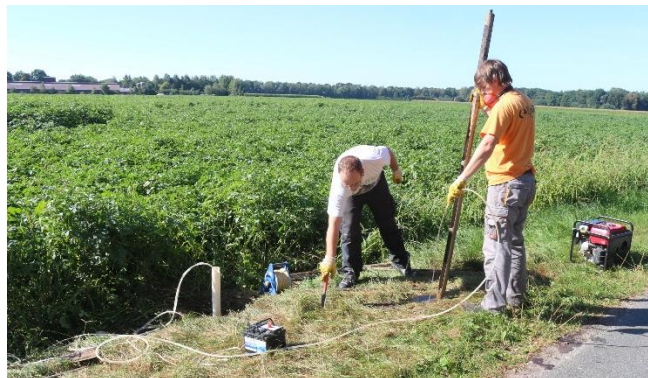
Abb. 1: Bau einer temporären Grundwassermessstelle mittels Rammkernsondierung am Standort Kleinringer Wösten neben einem Kartoffelfeld
