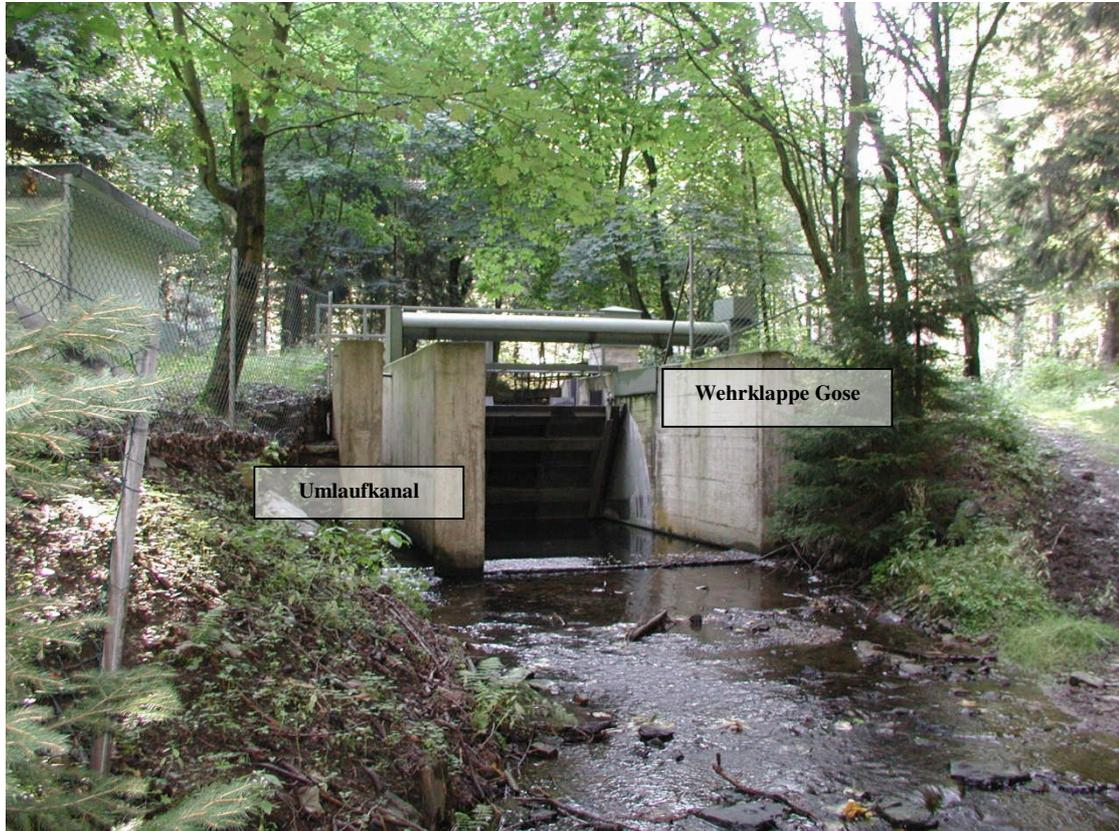
Abb. 3 Goseableitung Gose unterhalb mit Umlaufkanal
