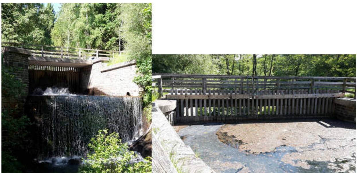
Abb. 1: Nadelwehr am Hüttenteich, links: aus Richtung Unterwassers, rechts: aus Richtung Hüttenteich
