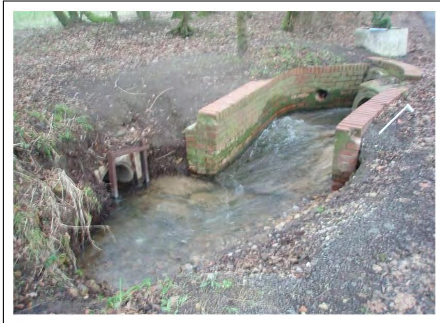
**Foto 18: Trennbauwerk Hönebach, Auslauf Verbindungsgraben**
