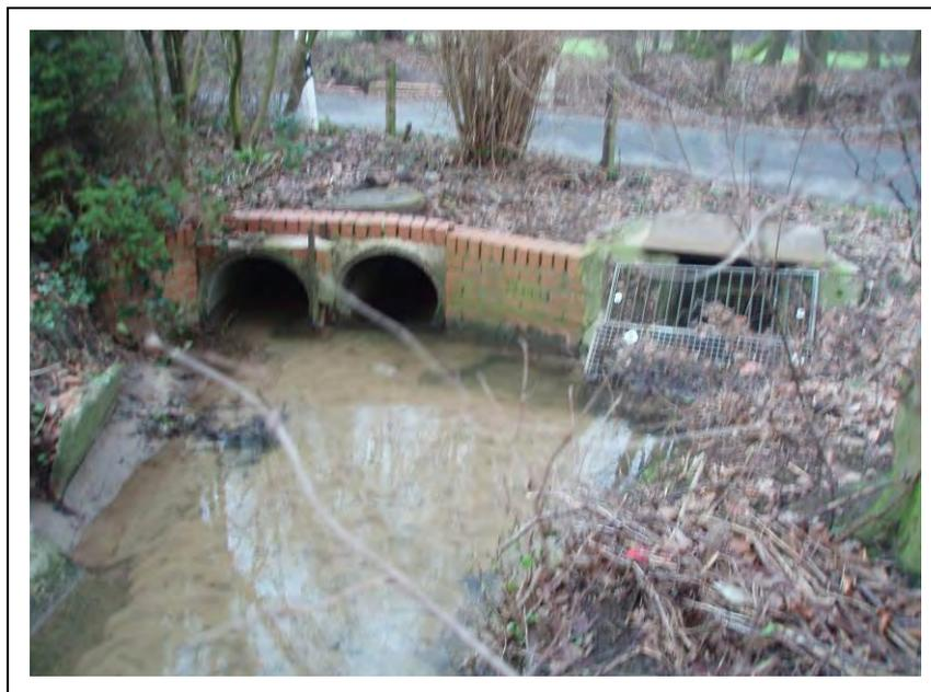
**Foto 15: Trennbauwerk Hönebach, Einlauf Verbindungsgraben**
