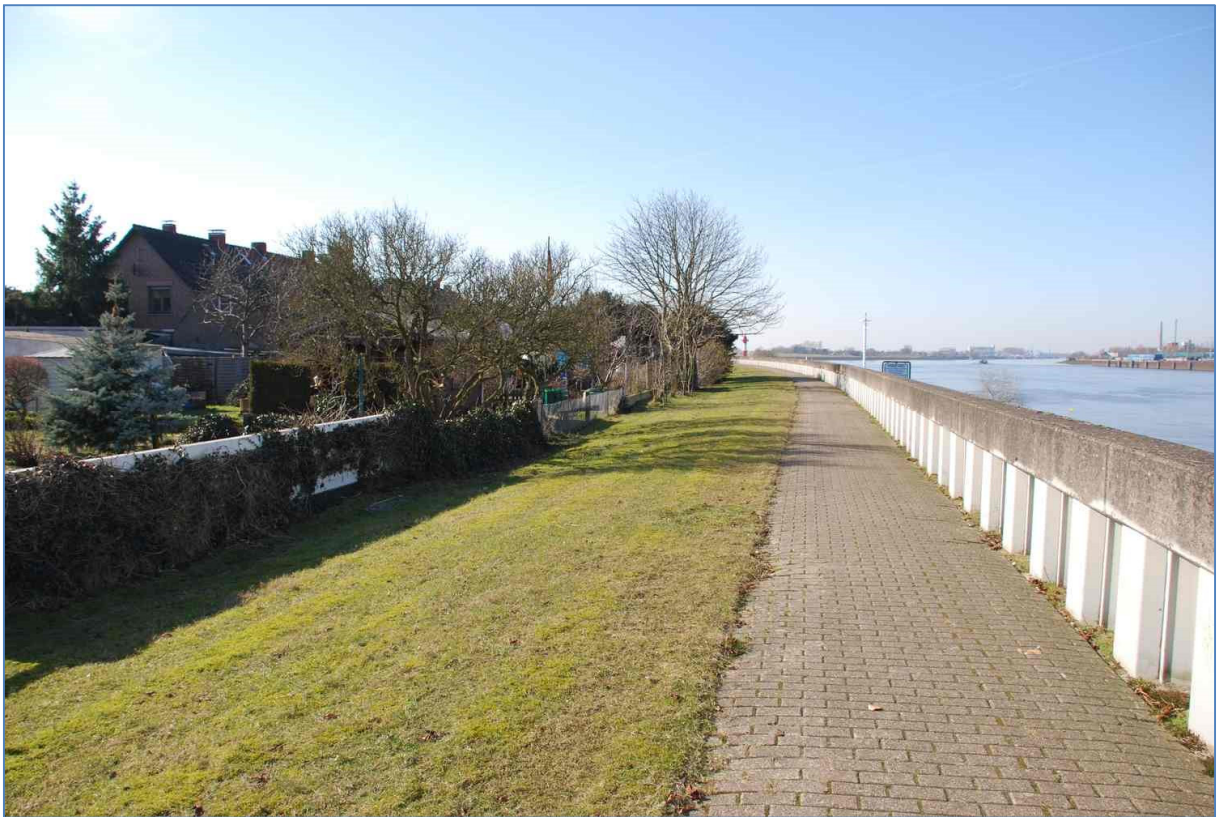
Abbildung 2: Weg und Binnenberme landseitig der bestehenden Spundwand
