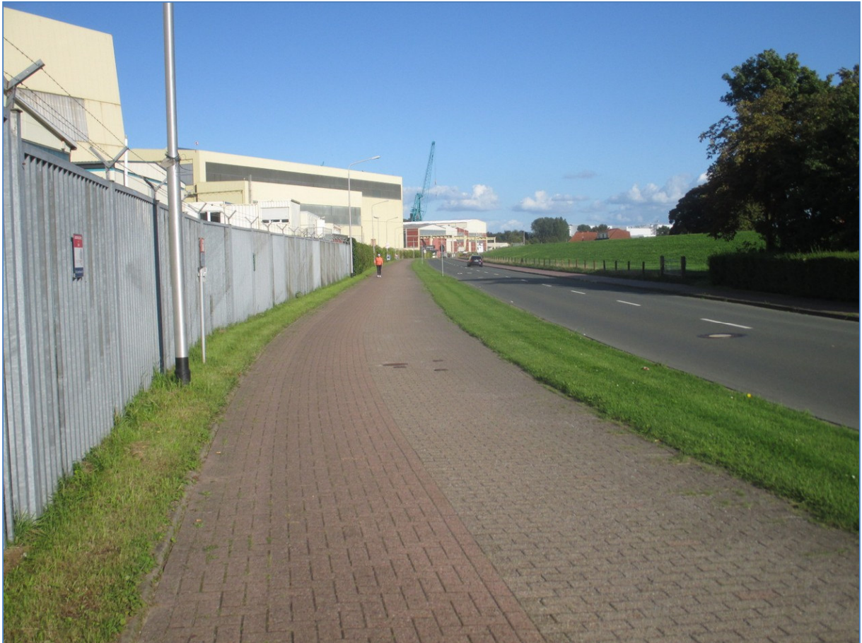
Abbildung 8: Rad- und Fußweg zwischen dem Zaun der Lürssen-Werft und der Industriestraße im Bereich des neuen Schaarts
