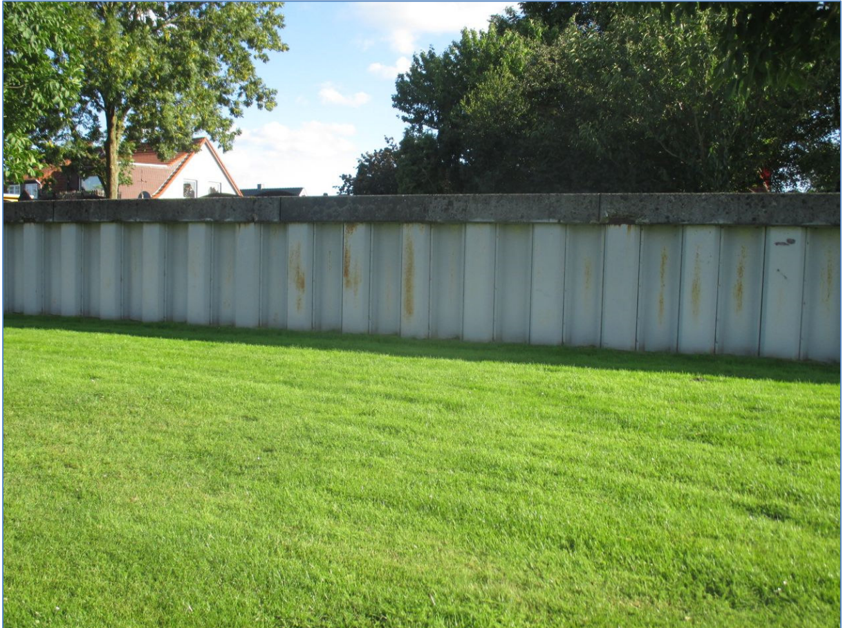
Abbildung 10: Blick auf die Spundwand von der Weser
