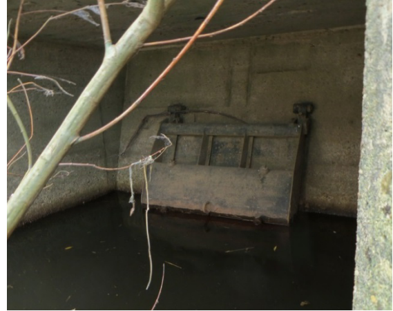
Abbildung 5: Rückschlagklappe Flutmulde
