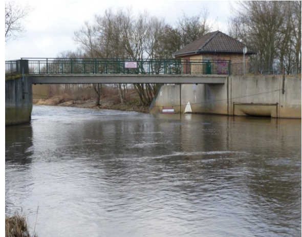
Abbildung 3: Wehr, Ansicht Oberwasser inkl. Umflutkanal
