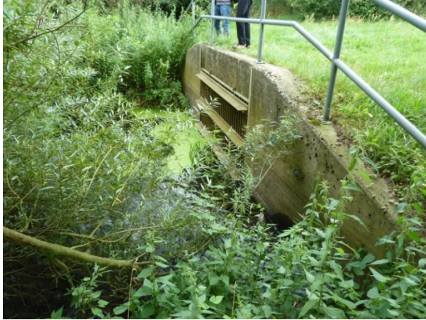
Abbildung 4: Durchlass mit Rohranbindung zur Aller
