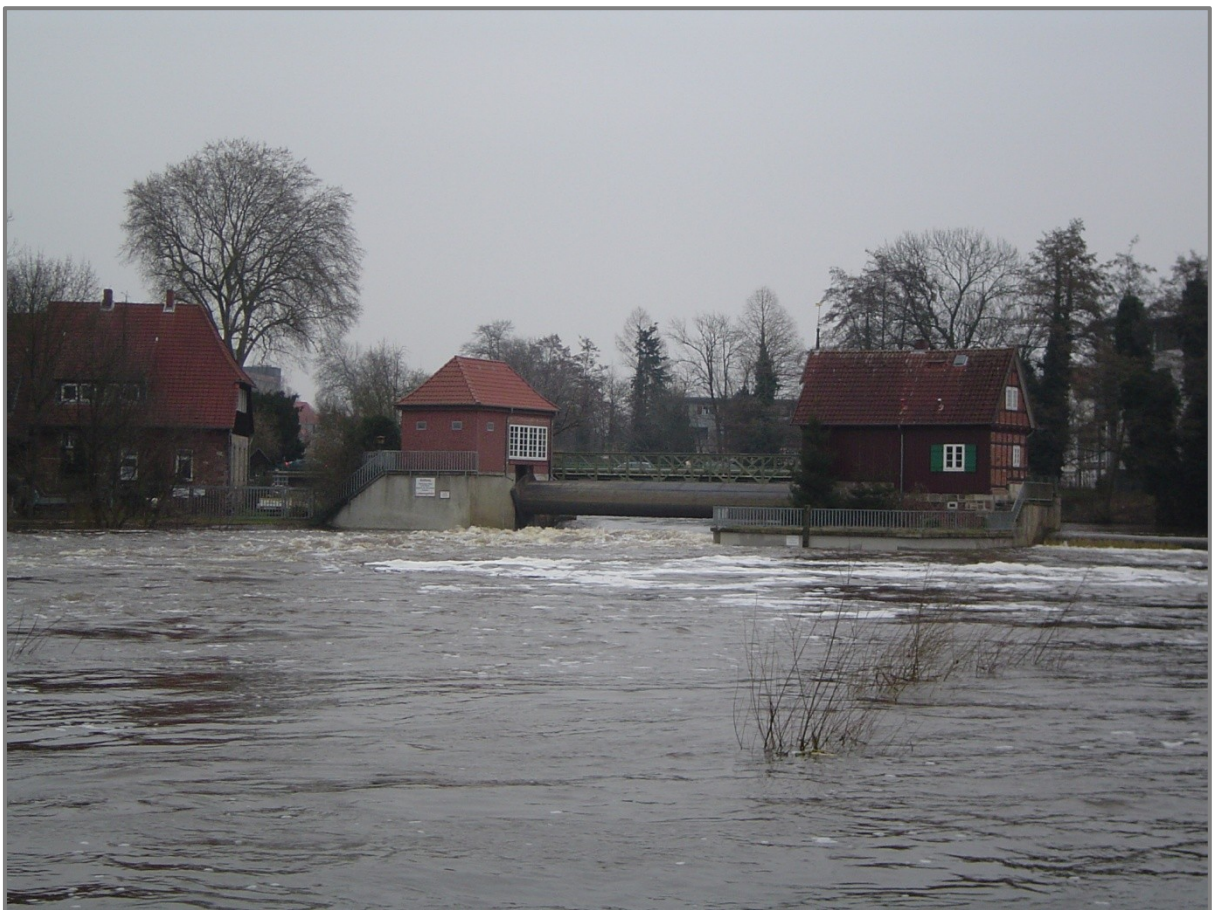
Wehranlage Celle bei Hochwasser am 29. Januar 2008, Wasserstand am Pegel Celle: 427 cm
