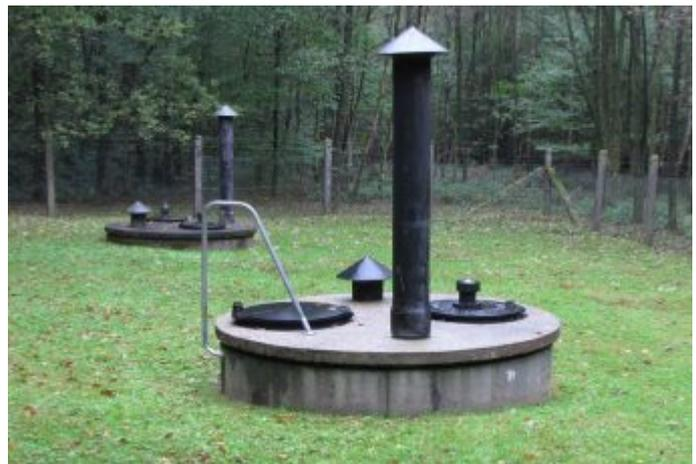
Abb. 29: Förderbrunnen in einer Schutzzone I bei Limberg.
