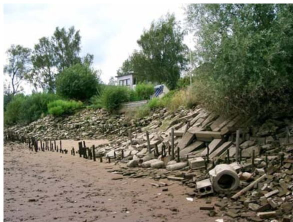
Foto 16: Uferverbau durch Steinschüttung im Funktionsraum 1 (BIOS)
