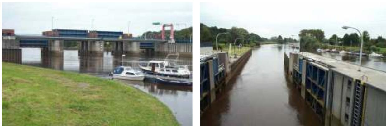
Abb. 3-20: Wehrfelder und Schleuse des Lesumsperrwerks
