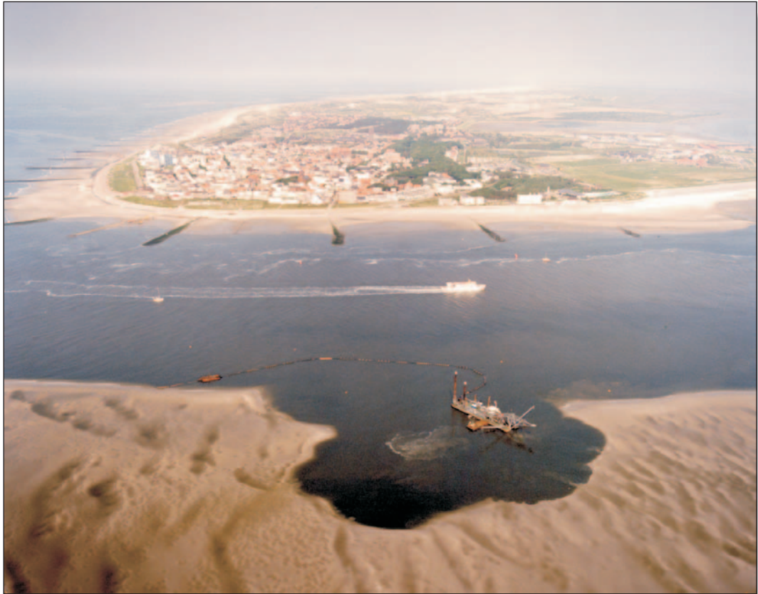
Insel Norderney von Westen mit der Robbenplate und dem Spülbagger der Strandaufspülung 2000
