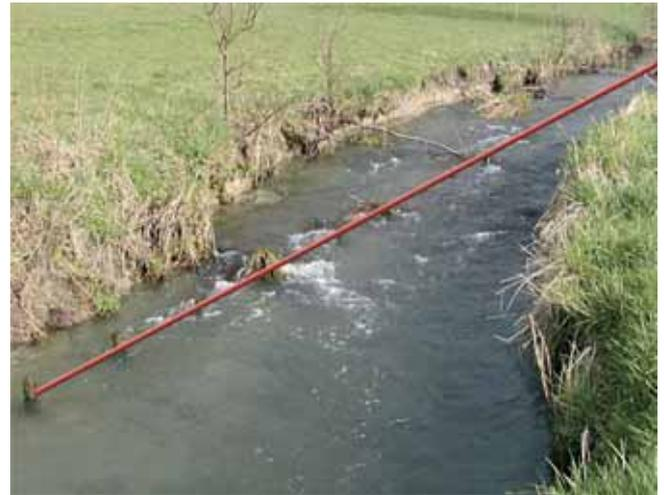
Abb. 1: Beginnende eigendynamische Gewässerbettrestrukturierung am Beispiel der Leisse (Hochsauerland), (rote Linie = ehemalige Uferlinie des Ausbauprofils)
