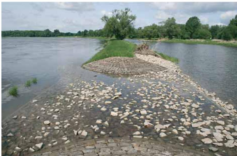
Abb. 3: Absenkung des Längswerkes im Mai 2006 mit Blick stromab bei fallendem Wasserstand
