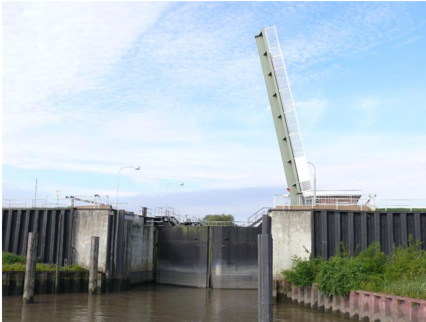
Abbildung 1: Sperrwerk Abbenfleth, Ansicht auf die Aussenseite
