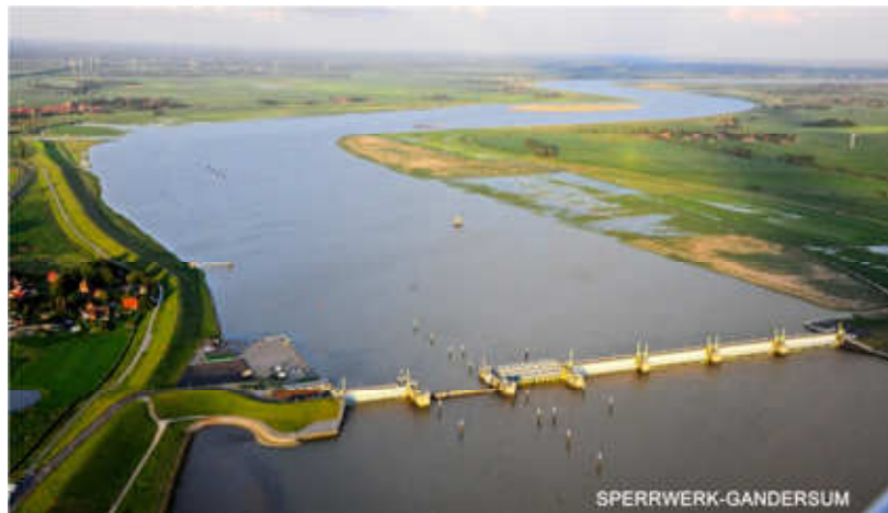
Afb. 21: Emssperwerk bij Gandersum (Foto: Meyer Werft GmbH & Co.KG 2011)
