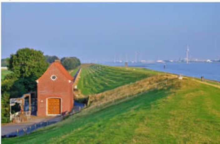
Afb. 9: Gemaal en dijk bij Ditzum (Foto: H.-J. Zietz)
