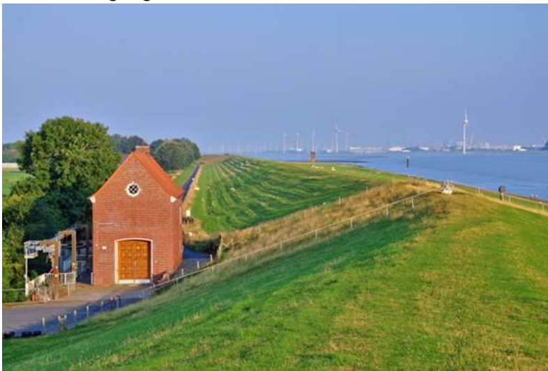
Abb. 9: Schöpfwerk und Deich bei Ditzum (Foto: H.-J. Zietz)
