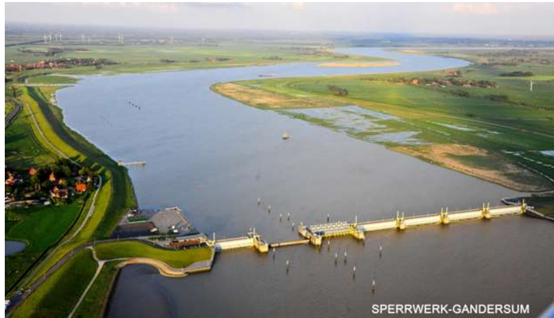
Abb. 21: Emssperwerk bei Gandersum (Foto: Meyer Werft GmbH & Co. KG 2011)
