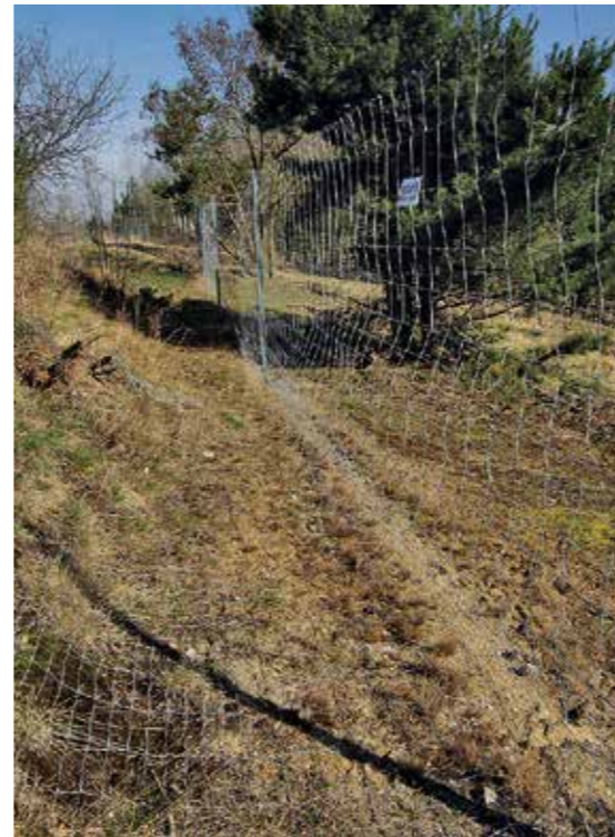
Für Gatterwild: 180 cm hoher Knotengitterzaun mit Schürze als Untergrabeschutz (Foto: B. Pott-Dörfer)
