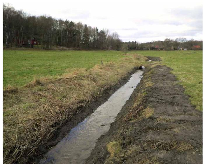
Abb. 156: Nach der Unterhaltung sind alle Ufer- und Sohlstrukturen zerstört, Oberlauf Vierenbach (Ilmenau/Elbe), (SK 6, LAWA-Typ 16).
