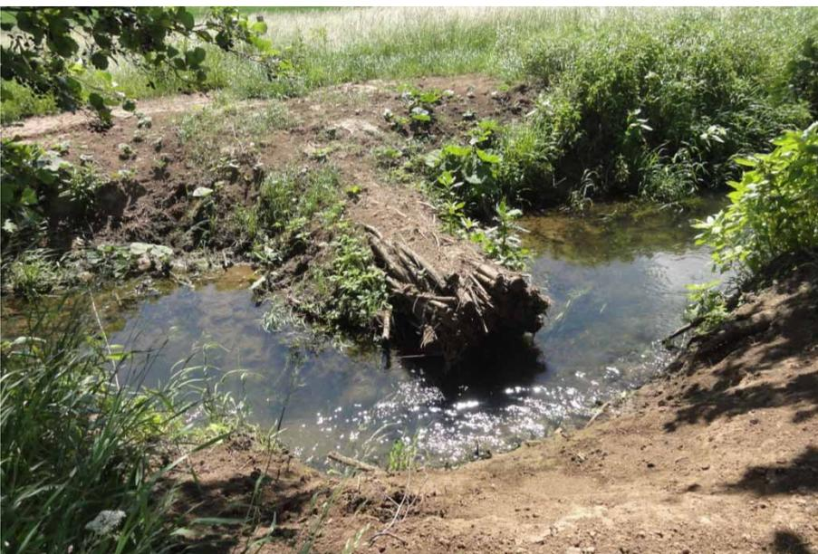
Abb. 104: Der Einbau von Strömungslenkern ist eine geeignete Maßnahme um über gezielte eisdynamische Prozesse die Strukturvielfalt zu erhöhen. Die beginnende Krümmungserosion, hier an der Ihme, ist deutlich erkennbar, (SK 3, LAWA-Typ 18).
