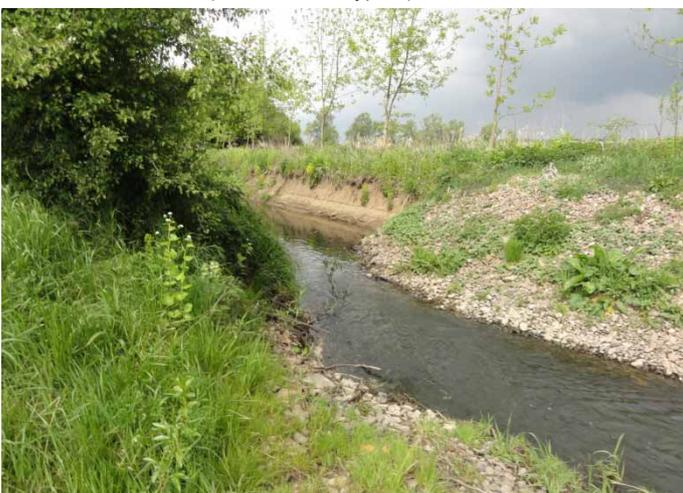
Abb. 109: Maßnahme zur Strukturverbesserung an der Bückeberger Aue (Weser) oberhalb Evesen: Kiesaufschüttungen verkleinern das durch Breitenerosion im Hintergrund erkennbare überbreite Profil. Die Strömungsdiversität wird deutlich erhöht, (SK 4, LAWA-Typ 15).
