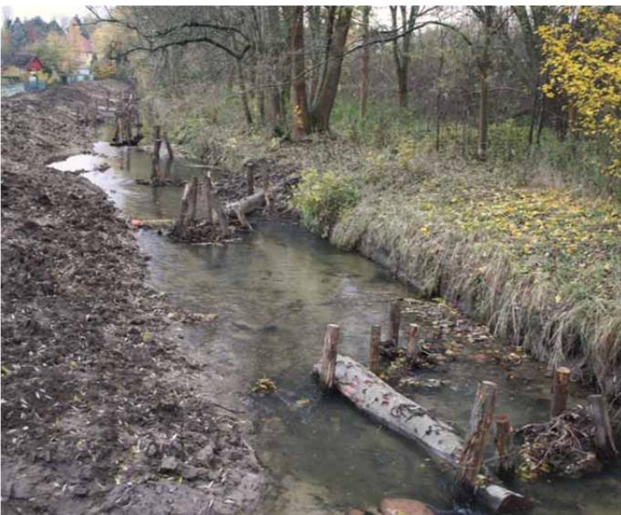
Abb. 71: Mittelriede (Schunter/Oker/Weser), Einbau von Strömungslenkern zur Strukturverbesserung, (SK 4, LAWA-Typ 18).
