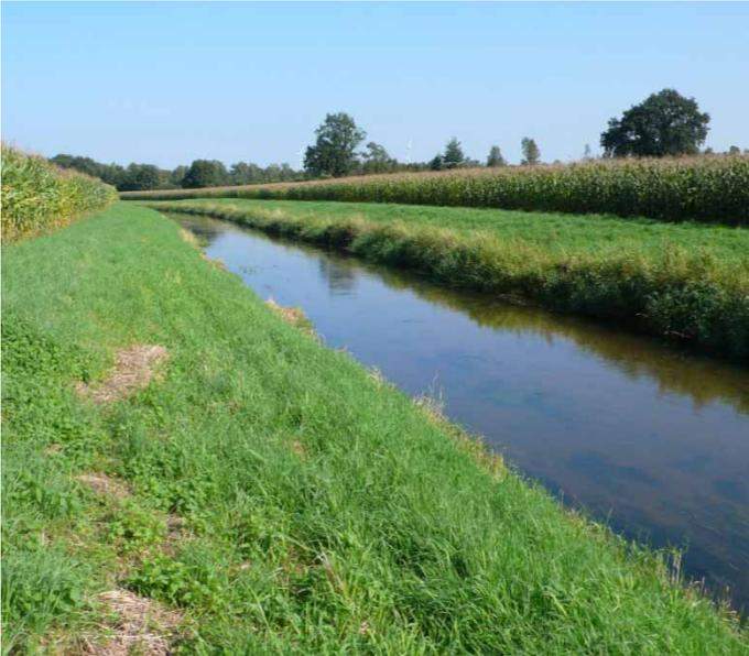
Abb. 199: Siede (Große Aue/Weser), sehr stark veränderte, strukturarme Strecke mit Maisfeldern bis an die Böschungskrone und breitem, gerade verlaufendem Trapezprofil, (SK 6, LAWA-Typ 15).
