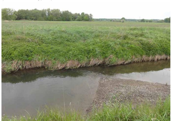
Abb. 112: Strömunglenker aus Kies erhöhen die Strömungs- und Tiefenvarianz und sollen eine eigendynamische Laufveränderung bewirken. Da die Maßnahme zum Zeitpunkt der Aufnahme neu war, ist noch keine Krümmungserosion erkennbar. Bückeberger Aue etwas unterhalb Abb. 109, (SK 4, LAWA-Typ 15).
