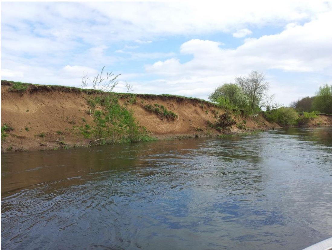
Abb. 4: Einsetzende Eigendynamik, Abbruchkante am Ufer der Leine.
